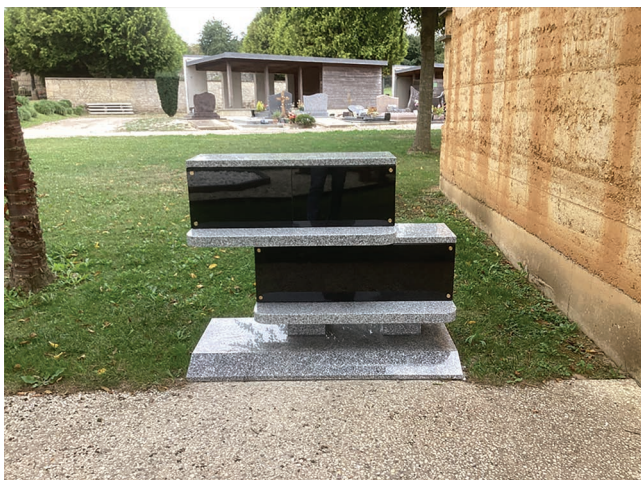
Mise en place de colombariums dans le cimetière.
