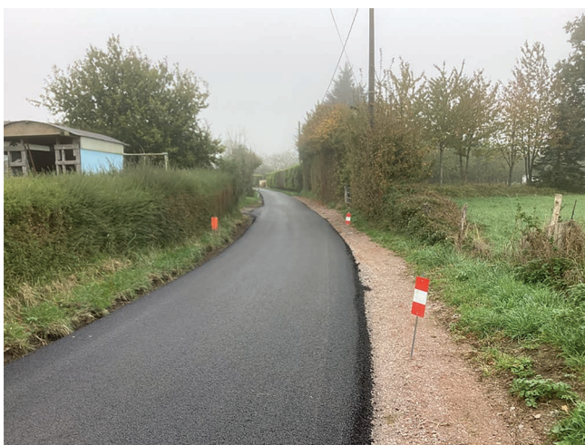
Travaux « rue des hauts vents » (pluvial et voirie)
